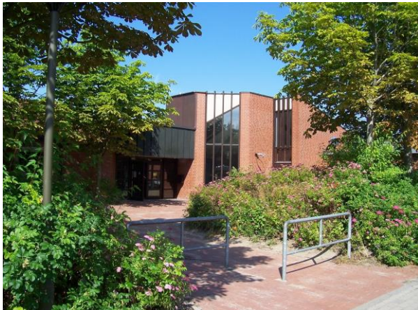
Das Schulgebäude bekommt einen Brandschutz nach den modernsten Vorgaben
